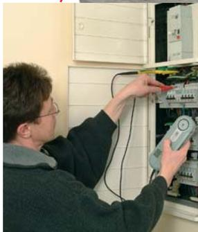
Contrôle d'isolement sur tableau entre
