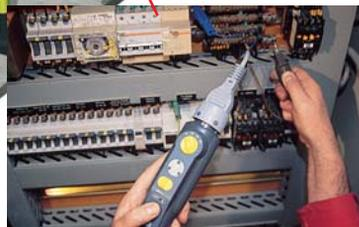
Contrôle des différentiels avec le
